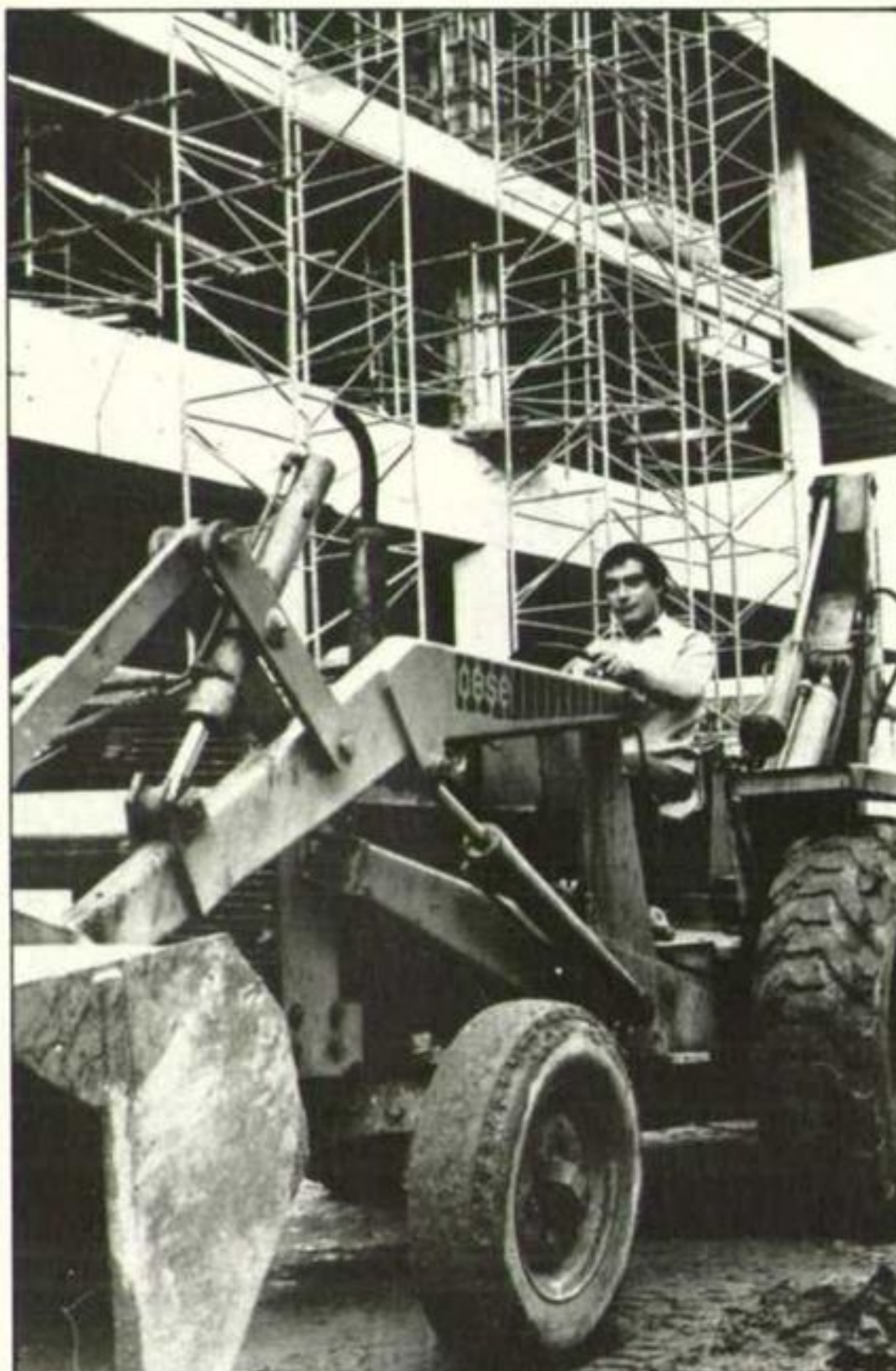
Garcia, na sede em obras: força da tradição
