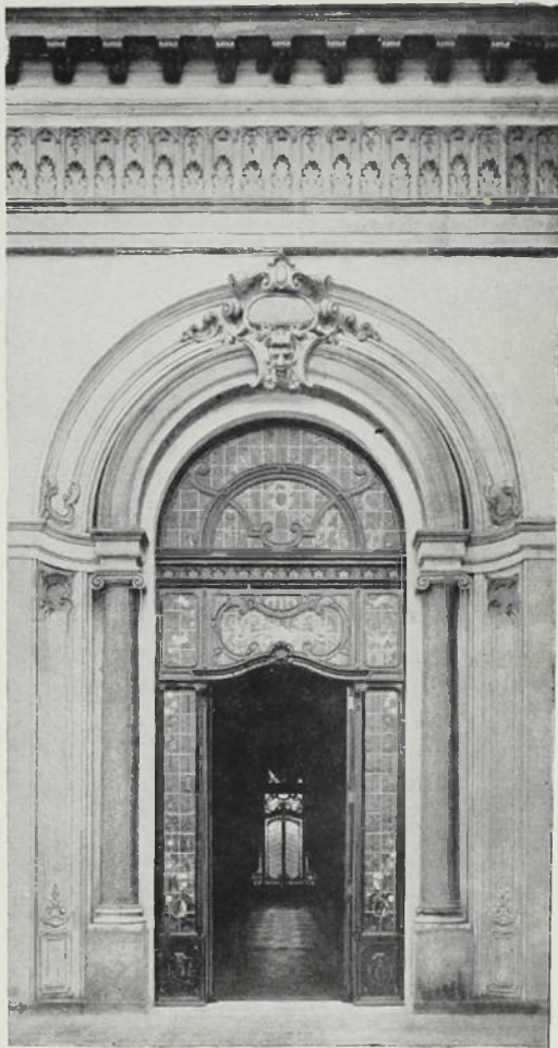
Porta da fachada
