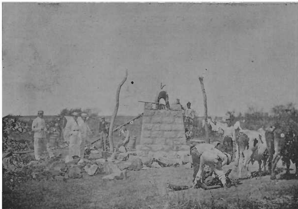
CONSTRUÇÃO DO MARCO DA FÓZ DO QUARAHYM
