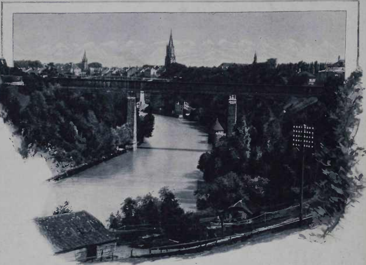
Berna com a grande ponte da via ferrea do Aar.
