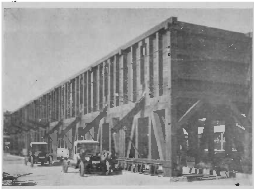
Silo para armazenamento e distribuição de pedra britada na Rua Bresser.
