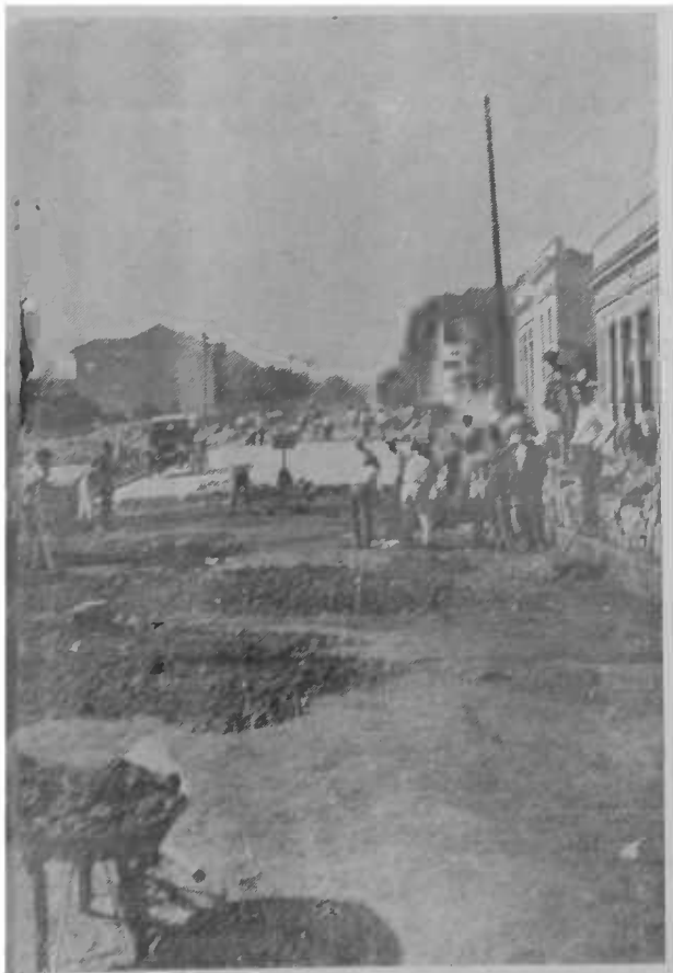
terreno e assentamento de paralelepípedos.
