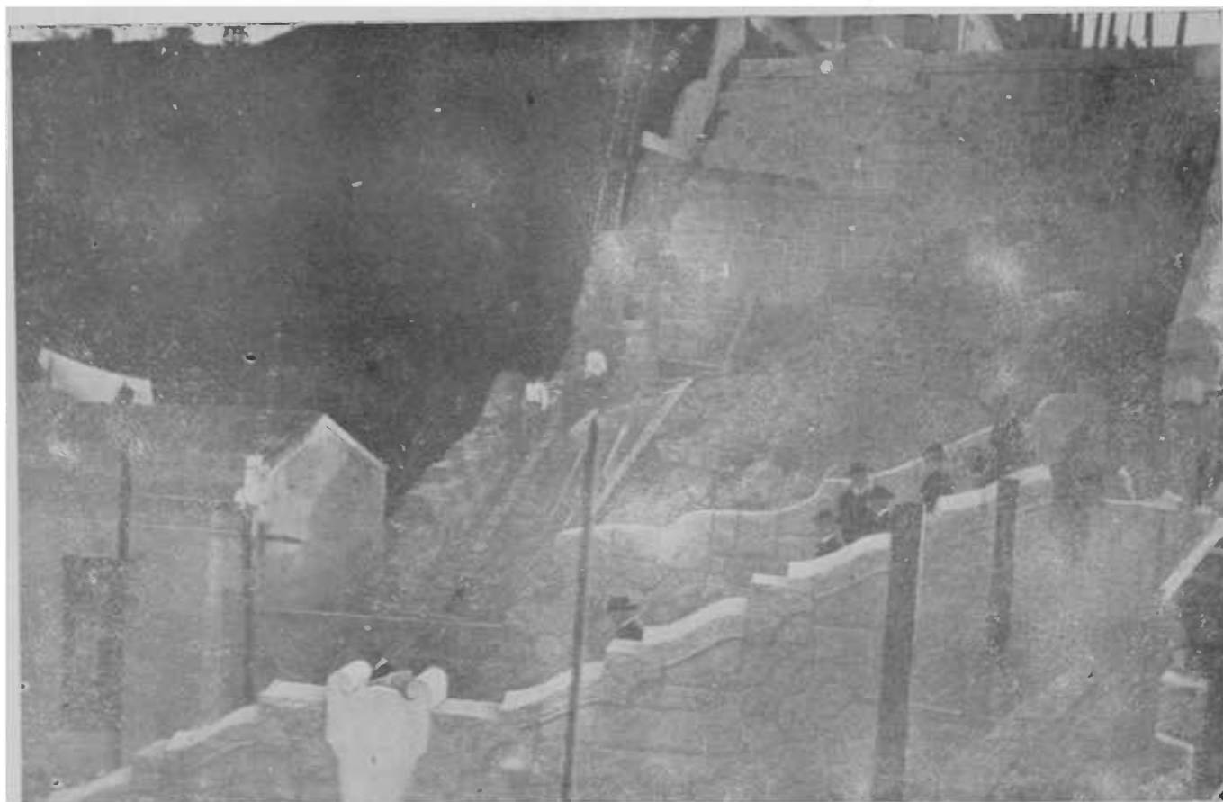
Os paredões de alvenaria de pedra das obras de transformação da ladeira do Carmo.
