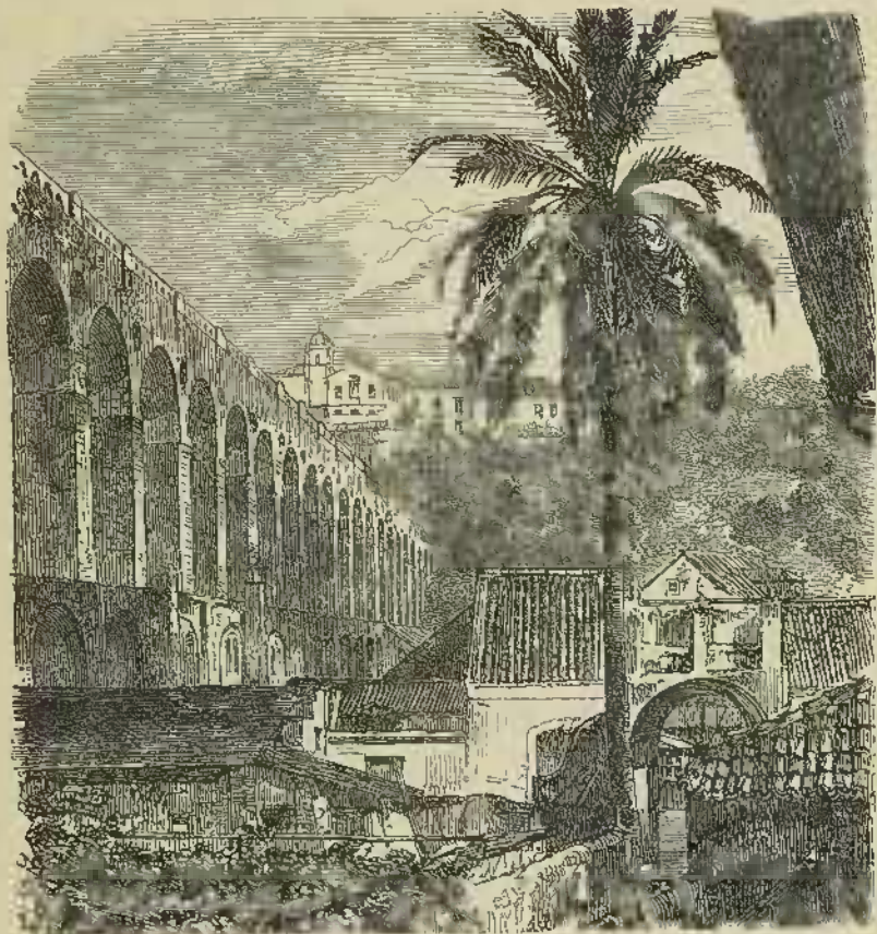
Aquädukt von Rio Janeiro.
